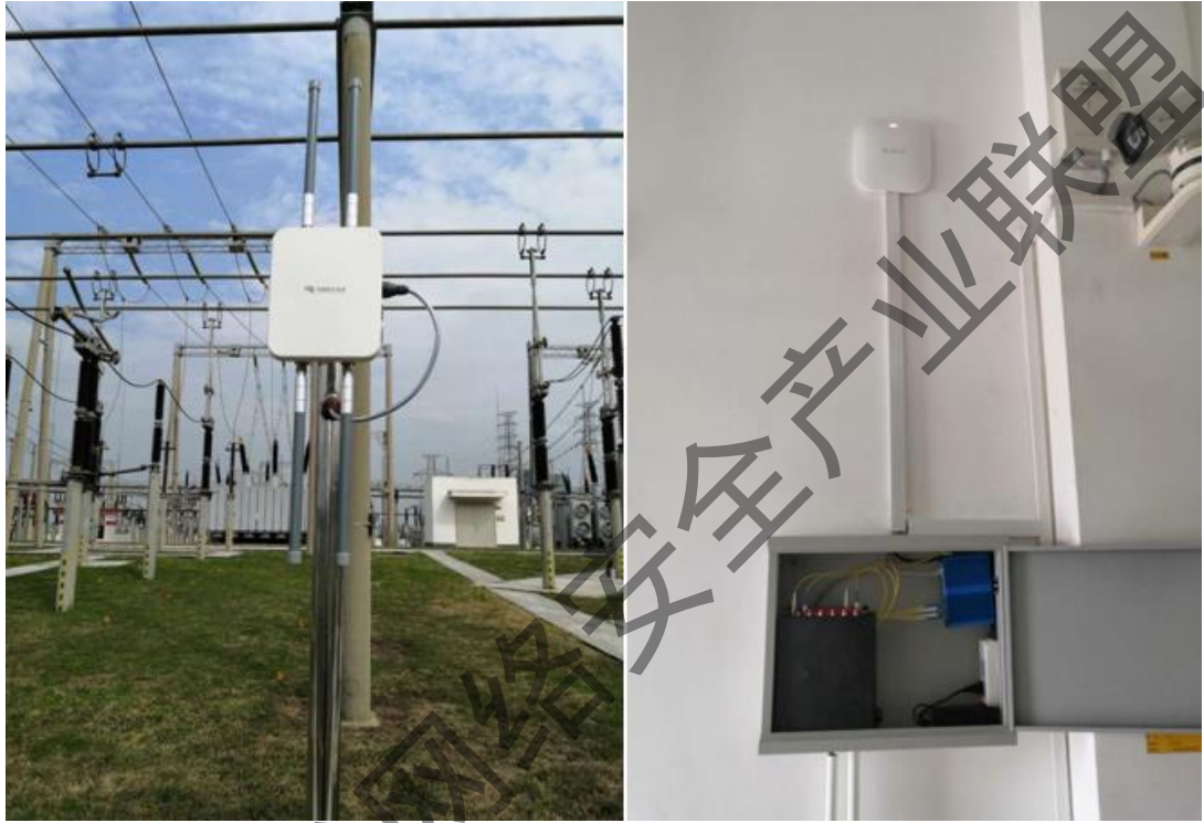
图：琅东变电站项目现场
