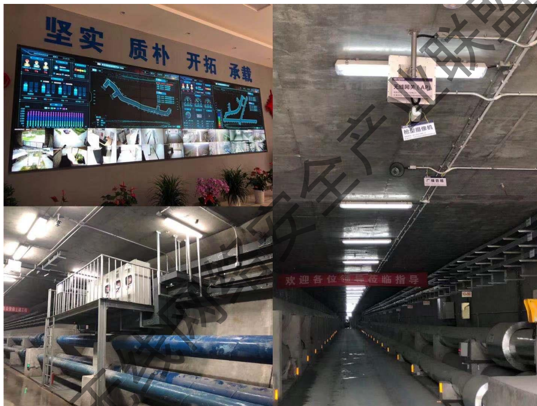
图：北京冬奥会综合管廊项目现场
