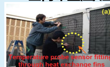
室外布置温/湿度传感器(探针法) [1]
