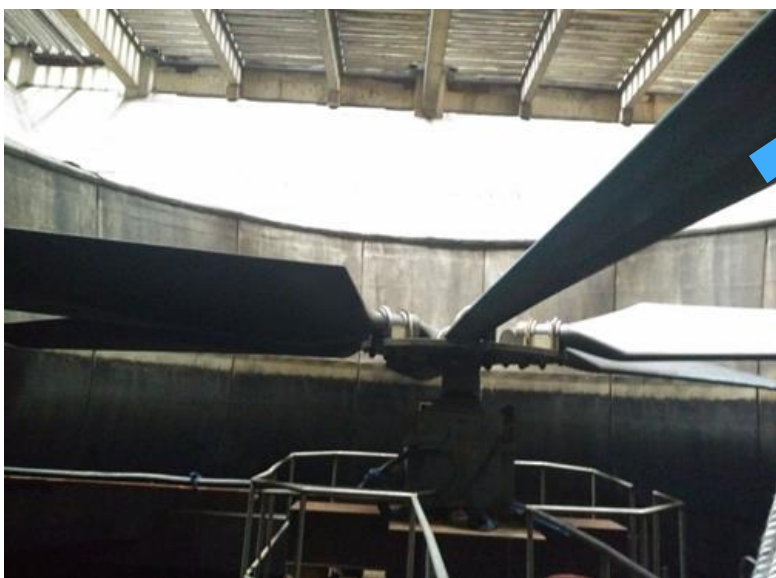
220Kw机力塔风机
