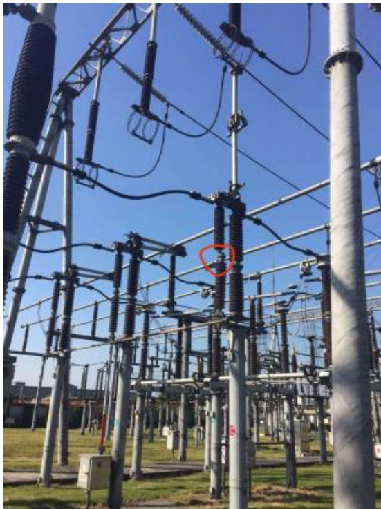
闸刀操作绝缘子
