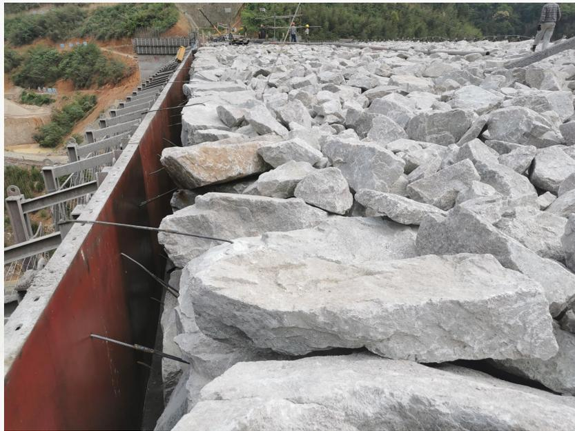
上游面模板采用翻转式钢模，钢模与块石之间按照设计的面层厚度预留间隙，堆石完成后一体化浇筑。
