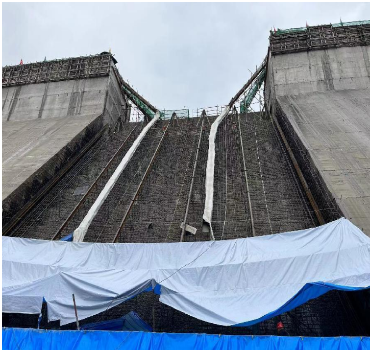
溢流坝混凝土浇筑
