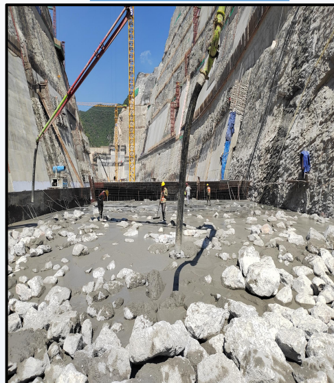
混凝土浇筑
