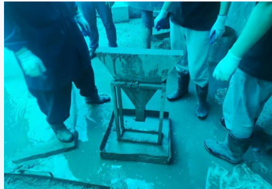
V漏斗时间检测
