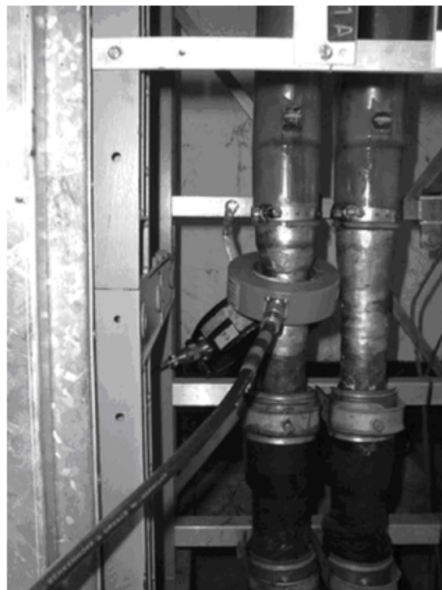
图d18 安装在电缆上的商业化的电流传感器
