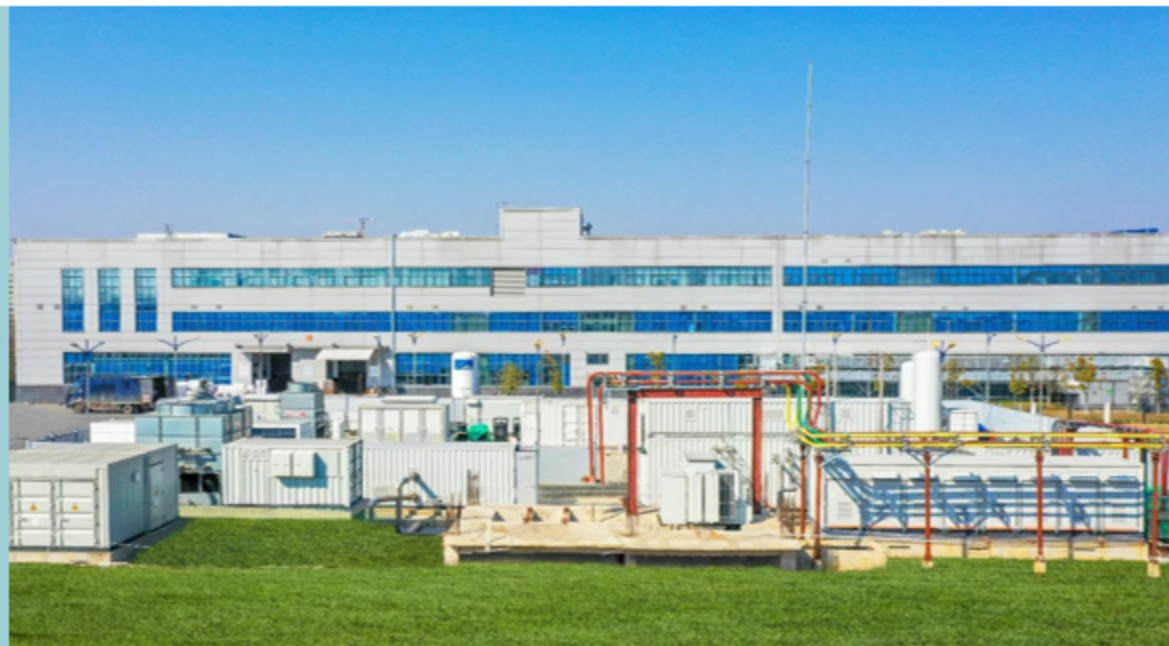
国内最大电解水制氢系统综合测试平台
