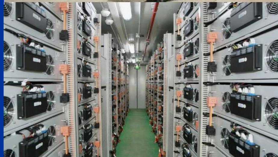
5MW超级电容器储能系统
