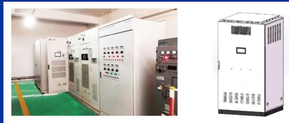
直流电压暂升暂降治理装置
